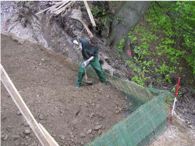
*“Fußverdichtung” im Frontbereich des Bauwerks*
