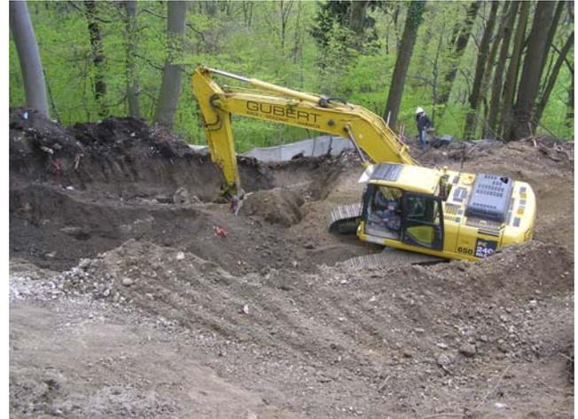
Herstellung der Aufstandsfläche. Länge und Breite gemäß den Tennisplatzabmessungen, Tiefe bis zu 14 m.
